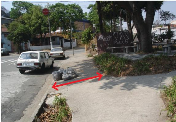
Fig. 3.2.8 Calçada com inclinação transversal excessiva.
