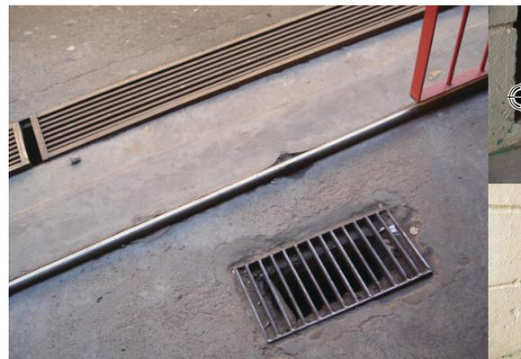
Fig. 3.2.10 Grelha com vão inadequado e trilho sobressalente dificultando a circulação da cadeira de rodas.
