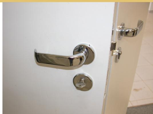
Fig. 4.2.3.3.1 Exemplo de maçanetas do tipo alavanca.
