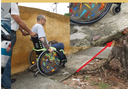
Fig. 3.2.7 Desnível na calçada ocasionado por canteiro com raízes de árvore.
