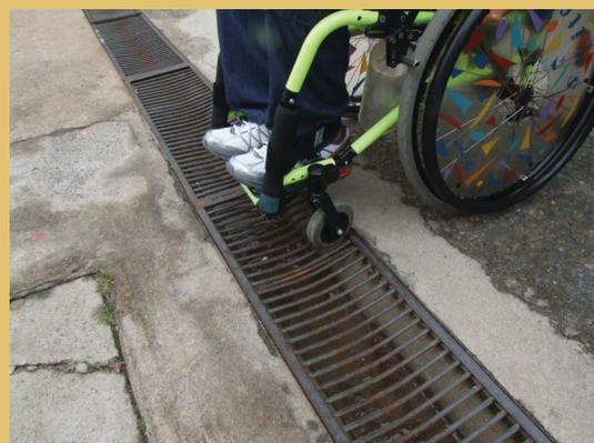
Fig. 4.2.2.3 Grelha com dimensionamento inadequado.
