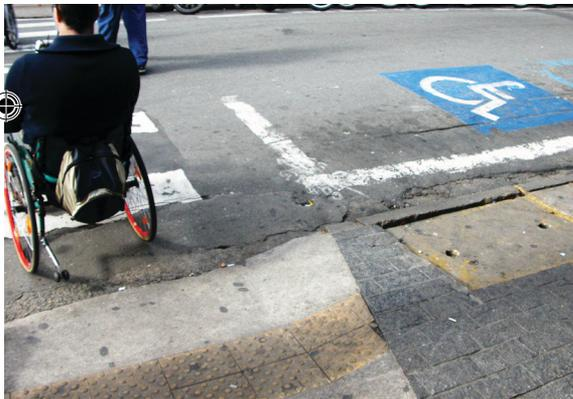
Fig. 3.1.2 Vaga reservada paralela à calçada, associada a rebaixamento de guia.
