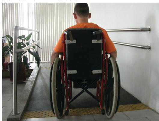
Fig. 4.3.1.1 Rampa com inclinação adequada, corrimãos duplos, guia de balizamento e sinalização tátil de alerta antes do início e após término.
