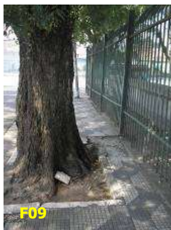
Exemplo de estrangulamento da circulação na calçada
