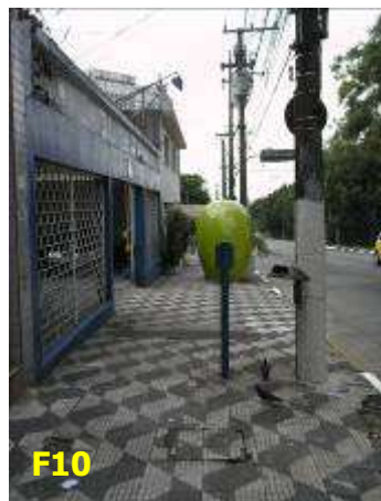
Orelhão instalado no meio da calçada sem sinalização tátil de alerta no piso
