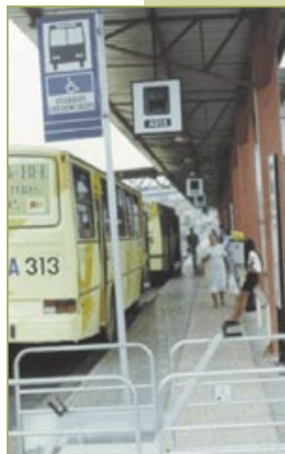
Foto 18 - Elevador junto à plataforma de embarque e desembarque de ônibus, atualmente desativado. Belo Horizonte, Estação Diamante, 1998.
