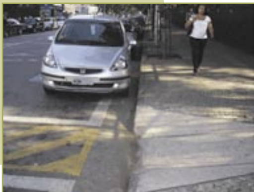
Foto 9 – Vaga Reservada de Estacionamento devidamente sinalizada e com rampa de acesso à calçada
