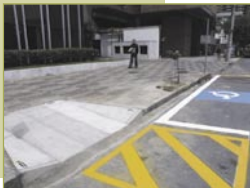
Foto 6 - Rampa de acesso a veículos credenciados - Belo Horizonte, 2006.
