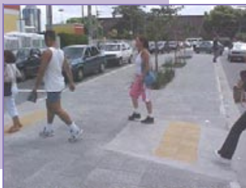
Travessia rebaixada com piso tátil
