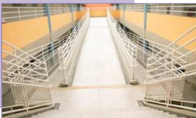
Rampa de acesso às salas de aula
