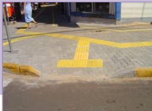
Pisos táteis para auxílio da mobilidade das pessoas com deficiência visual
