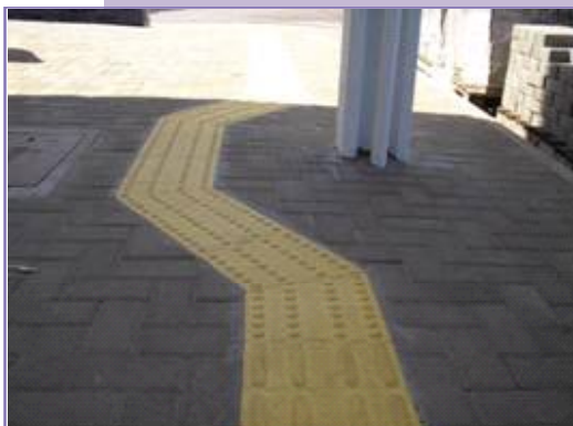
Pisos táteis para auxílio da mobilidade das pessoas com deficiência visual
