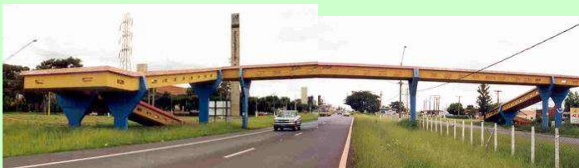
Figuras 300 – Travessia de pista expressa em área urbana por intermédio de passarela acessada por rampa. Sua inclinação deve respeitar o valor máximo de 8,33% com patamares de descanso de acordo com a fórmula apresentada [ i = (h \times 100/c) ] – ABNT NBR 9050:2004.
