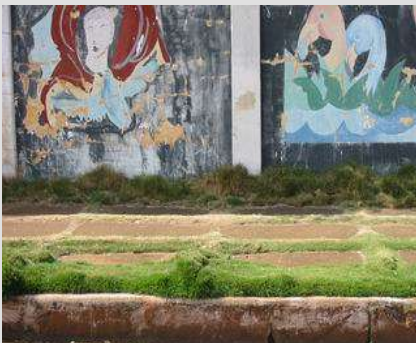
Figura 101 - Calçada descontínua, com grama, intermediando placas de cimento, dificultando a circulação.
