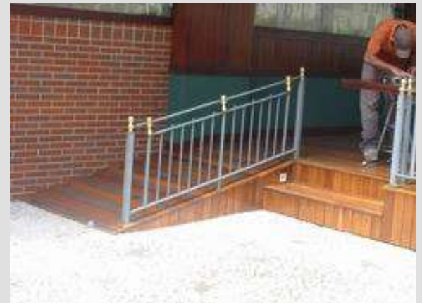
Figura 241 – Rampa de acesso a deck de madeira instalado sobre o passeio público como extensão de estabelecimento comercial. Chama-se a atenção para o obstáculo criado sobre a calçada e os equívocos do design do corrimão que não respeita as normas da ABNT.
