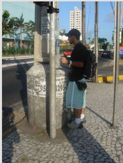
Figura 222 e 223 – Ao lado do suporte da botoeira de acionamento do semáforo temporizado para travessia de pedestres há um poste que impede a passagem. Para se evitar este problema deve-se padronizar o acionamento com a mão direita e implantar um piso tátil de orientação.
