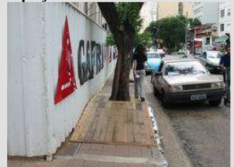
Figura 231 – Com o andaime da obra, o passeio público foi reduzido e a única passagem tem um tablado com uma árvore no meio. Embora todo o cuidado em oferecer uma rampa na travessia, a solução não é adequada, segura ou firme para uma pessoa em cadeira de rodas, idosos, muletantes etc.
