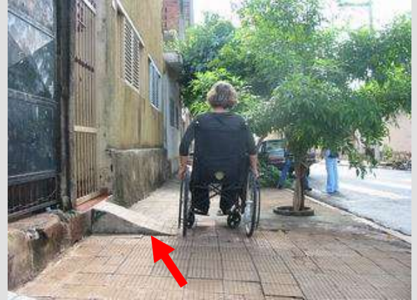
Figura 239 – Morador implanta rampa de acesso a seu imóvel sobre a calçada provocando, além do obstáculo na travessia longitudinal, um estreitamento da calçada.
