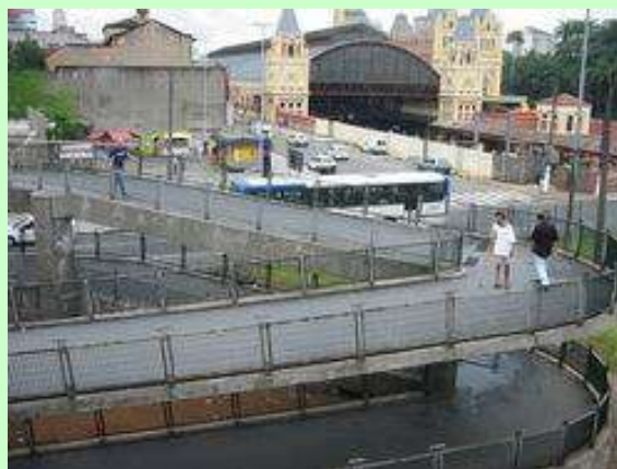
Figura 302 – Passarela de travessia com acesso por rampa curva cuja inclinação não pode ultrapassar 8,33% e seu raio interno tem que ser superior ou igual a 3,0 m, conforme ABNT NBR 9050:2004.
