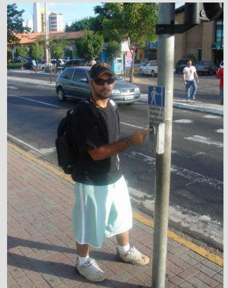
Figura 224 – Para se promover a equiparação de oportunidades neste semáforo temporizado e acionado por botoeira deve-se ter o piso rebaixado do meio-fio, possibilitando o acesso de cadeira de rodas.
